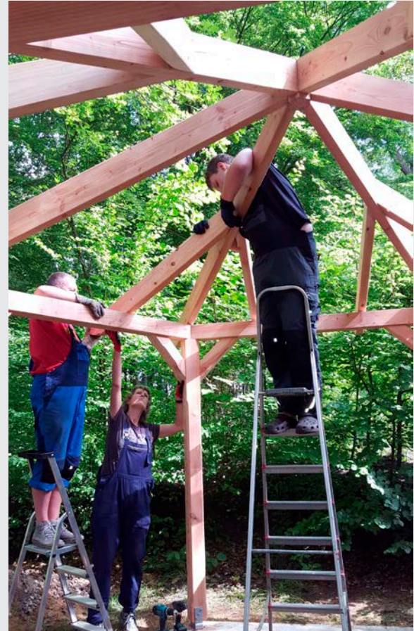
... der Pavillion wird aufgestellt ...
