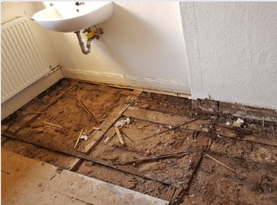
Erst einmal den Fußboden lösen ...
