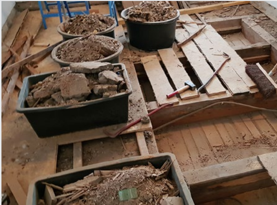
Immer tiefer wird gegraben ...
