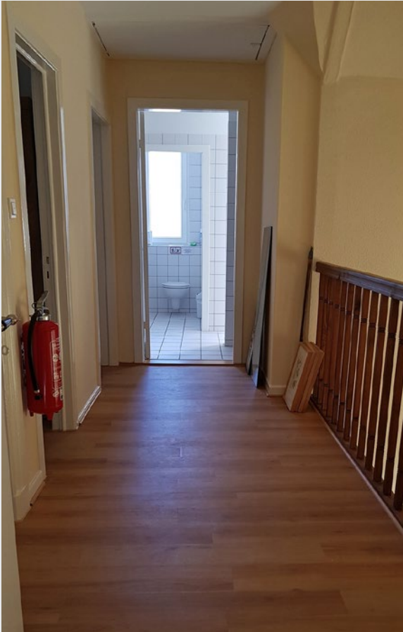
Flur – Blickrichtung Bad – erstrahlt in neuem Glanz
